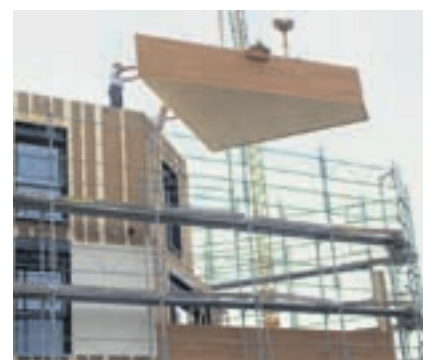
4 Massarbeit: Platzieren des fixfertigen Balkons.
