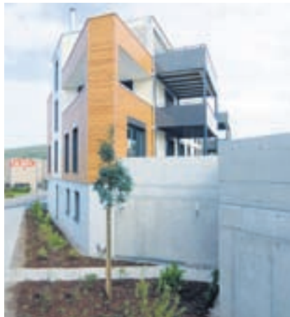
Die vorgelagerten Balkone und die Materialwechsel in der Fassade geben dem Gebäude das gewisse Etwas.
