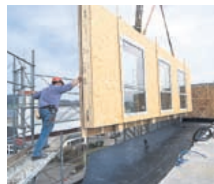
3 Einsetzen der Wände mit vormontierten Fenstern.
