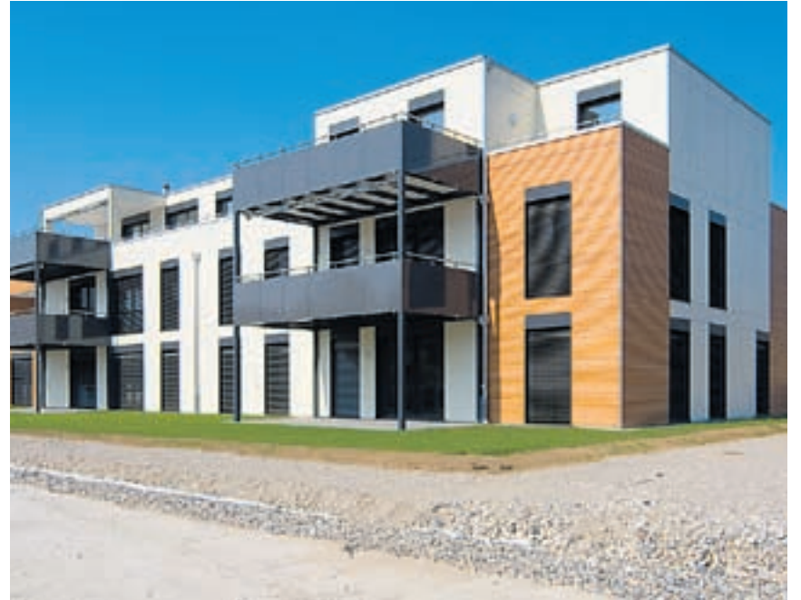
Auf der Rückseite des Gebäudes liegen die bezugsbereiten Wohnungen mit grosszügigen Balkonen.
