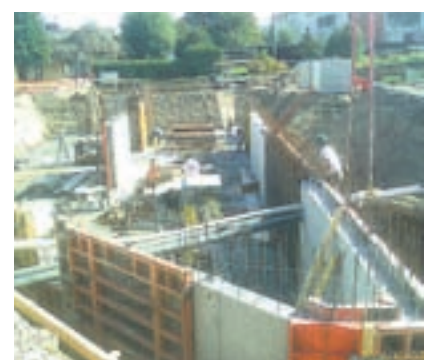
2 Das Fundament nimmt bereits Formen an.
