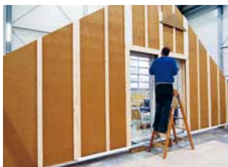
Fertigung der Einzelteile in der Produktionshalle.
