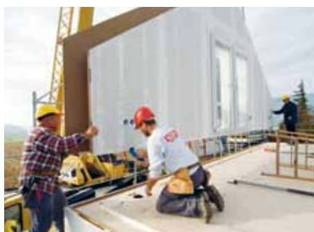
Montage der vorgefertigten Teile auf der Baustelle.
