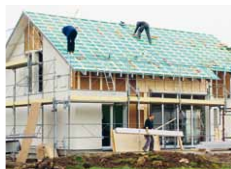
Fertiger Rohbau nach nur einem Tag Montagezeit.
