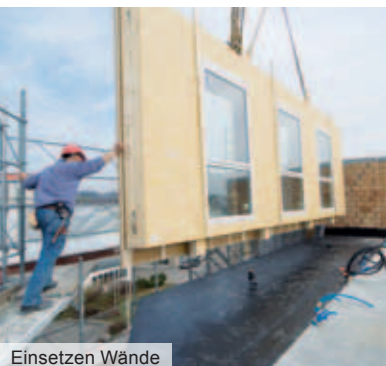
Einsetzen Wände
