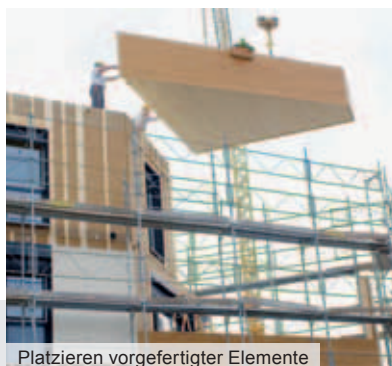
Platzieren vorgefertigter Elemente
